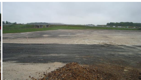
Vue du site derrière l'emplacement de la centrale
