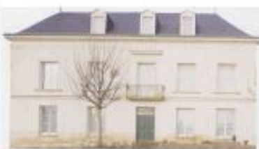
L'ancien relais de poste (vers 1746) au 53, rue nationale ;
