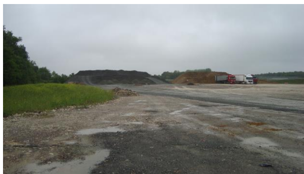
Vue du site depuis le portail d'entrée
